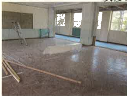
＜解体された保健室＞
